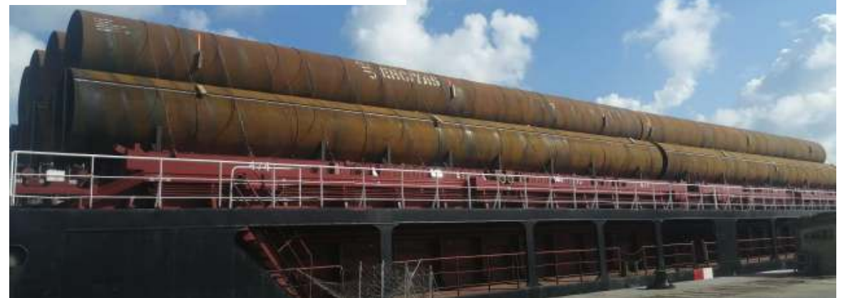
1,000 hektarlık yeni alanı kapsayan büyük liman projesine kazık boruları tedariki
