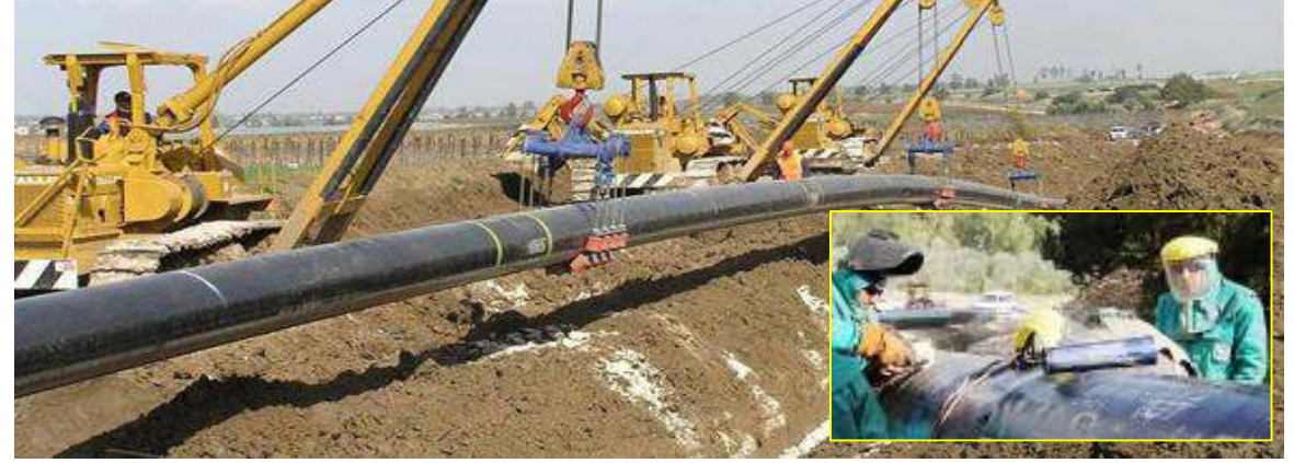
Eshel Hanesie, Ramat Hovav ikili doğal gaz boru hattı projesi
