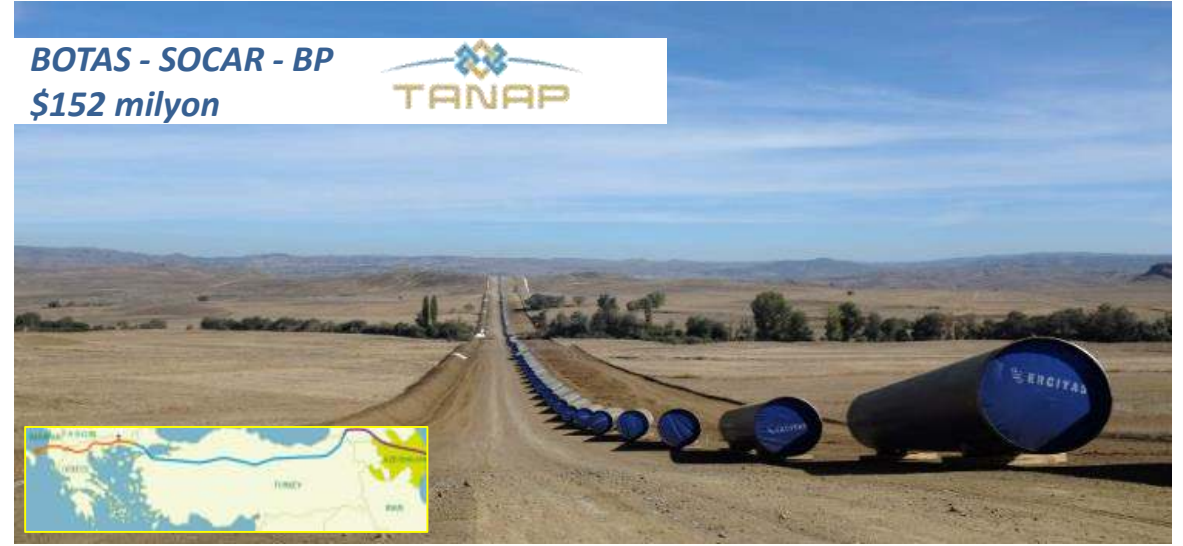
Azerbaycan gazını Avrupa'ya bağlayan en uzun gaz boru hattı projesi
